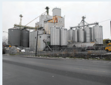
Site avant démolition
