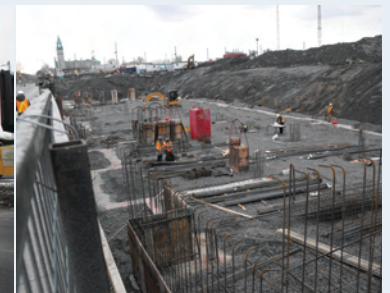
Excavation en cours
